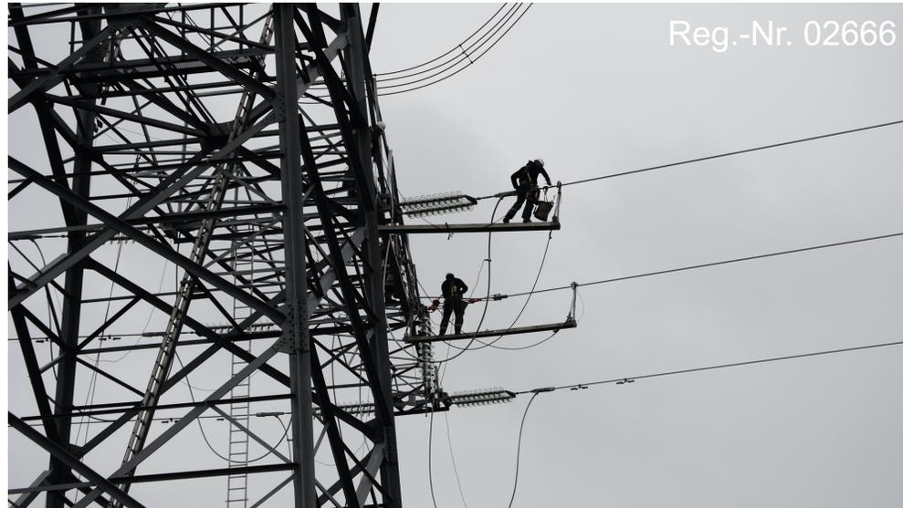
Ein Freileitungsmonteur führte Arbeiten an einem Mast in 21 Metern Höhe aus und verlor das Gleichgewicht und fiel etwa acht Meter herunter. Er prallte gegen die Stahlkonstruktion des Masts, erlitt schwere Verletzungen, überlebte aber. Der Grund für den tiefen Sturz war die unsachgemäße Verwendung der PSAgA. Bei solchen Arbeiten ist ein zugelassenes mitlaufendes Höhensicherungsgerät zu verwenden. Diese Anforderung wurde nicht erfüllt.
