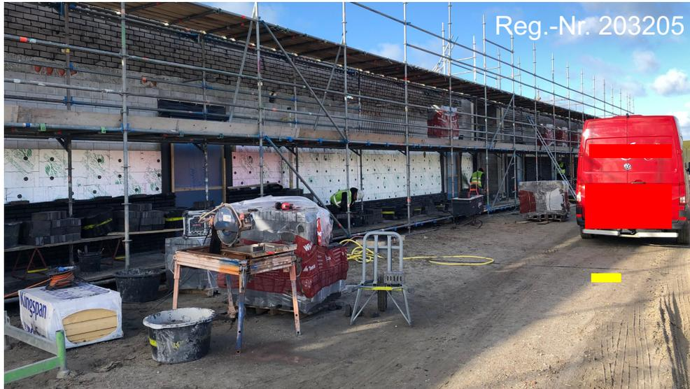
Beim Umbau eines Gerüsts fiel einem Gerüstbauer eine Stahlplanke aus den Händen. Im Erdgeschoss war ein Maurer am Werk. Vor dem Vorfall rief der Maurer dem Gerüstbauer zu, dass er hier arbeitet, aber der Gerüstbauer hat ihn nicht gehört.
