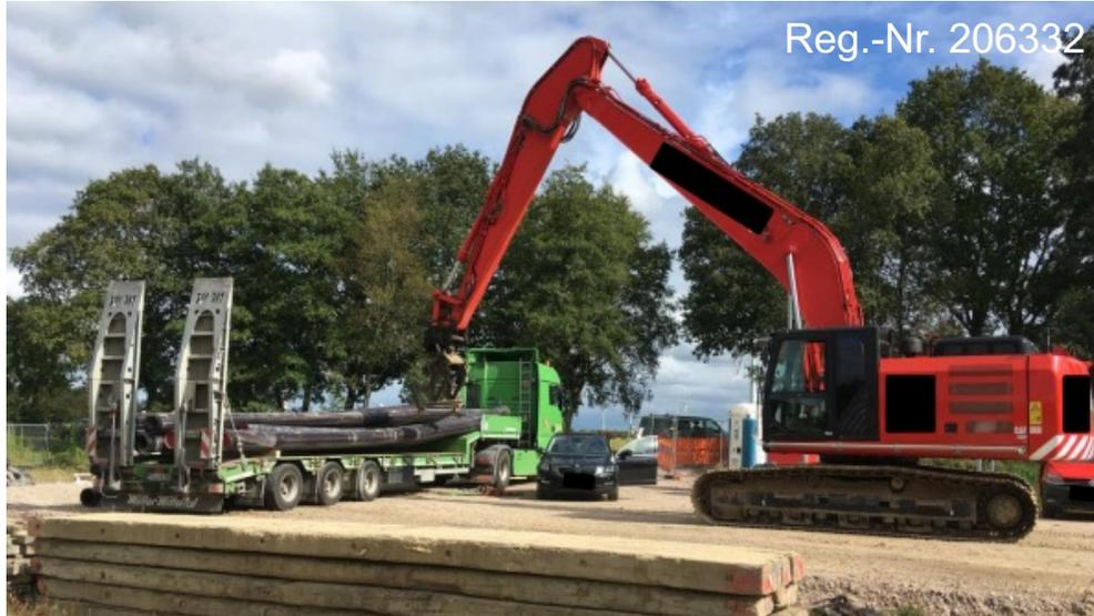
Mit einem Bagger mit Palettengabeln wurden 12 Meter lange Kunststoffrohre (400 kg pro Rohr) auf einen Tieflader geladen. Die Rohre begannen zu rollen, und der Lkw-Fahrer, der auf dem Tieflader stand, wurde getroffen, fiel vom Anhänger auf den Boden und wurde von einem Rohr getroffen. Der Lkw-Fahrer überlebte nicht.
