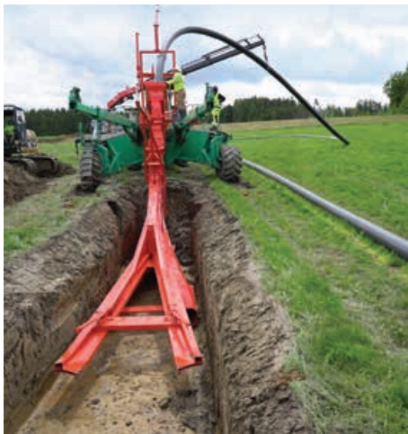
Ausgehobene Startgrube vor dem testweisen Einzug von Schutzrohren
